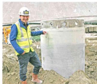
Für die Bohrpfahlwand werden 314 Stück überschnittene Bohrpfähle mit einem Durchmesser von 120 cm hergestellt. Im Bild Bmstr. DI Martin Rapp (Porr Bau)
